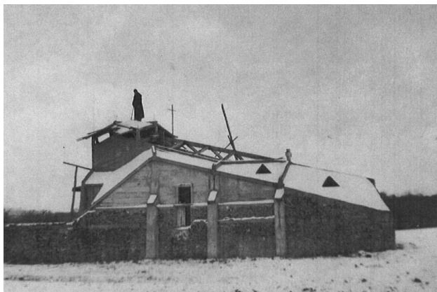
О. Евфимий на крыше церкви во время строительства
