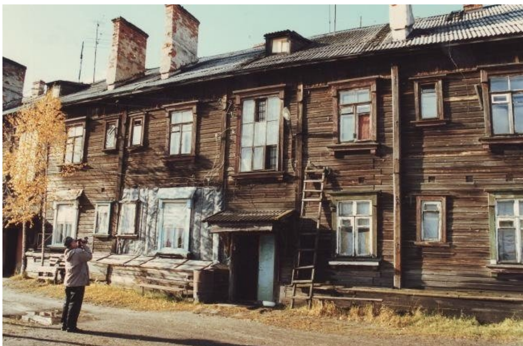
Изолятор Печорлага (г. Печора, Стадионная ул., 22). Здание, в котором в 1950-57 находился изолятор временного содержания заключенных Печорлага, в наст. время является жилым домом. Двухэтажное здание из бруса находится в аварийном состоянии; в некоторых окнах сохранились решетки (фотофиксация 2004)
